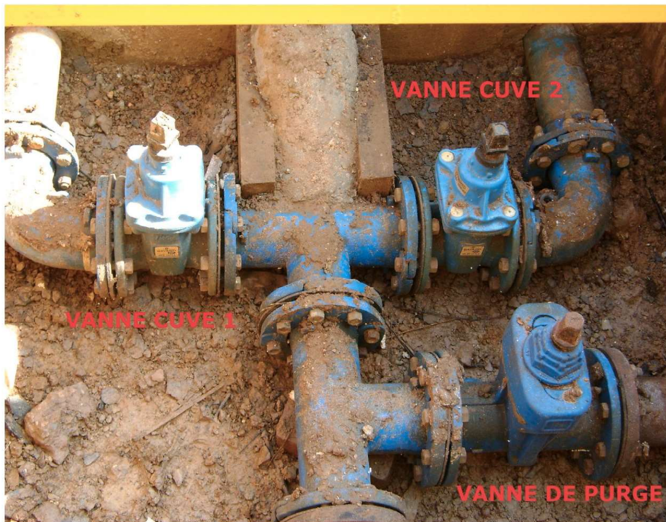
Figure 9 : Localisation des vannes alimentant les cuves 1 et 2 au droit de l'interconnexion avec Evreux Porte de Normandie
